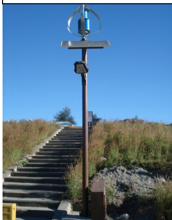
Mo-Energy Hybridanlage bestehend aus: LED-Straßenleuchte PV-Module 0,3 kW Windrad
