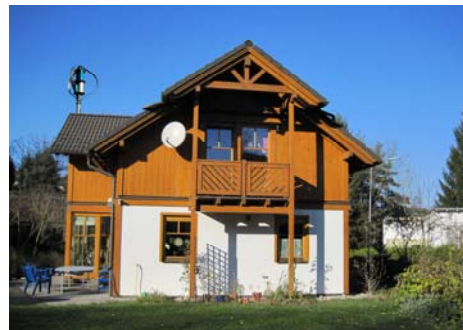
0,3 kW Mo-Energy auf dem Hausdach
