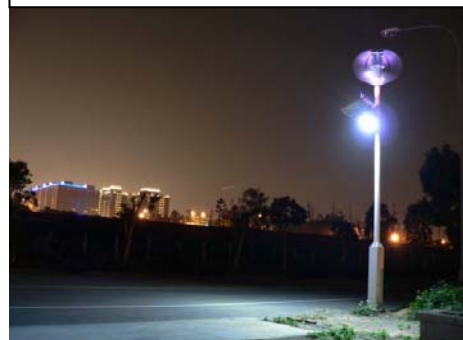
Mo-Energy Hybridanlage bestehend aus: LED-Straßenleuchte PV-Module 0,3 kW Windrad
